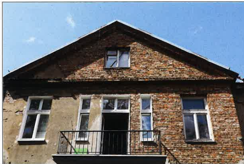
Górna część ryzalitu w elewacji frontowej.
