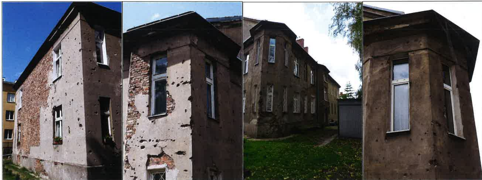
Widok poszczególnych fragmentów elewacji.
