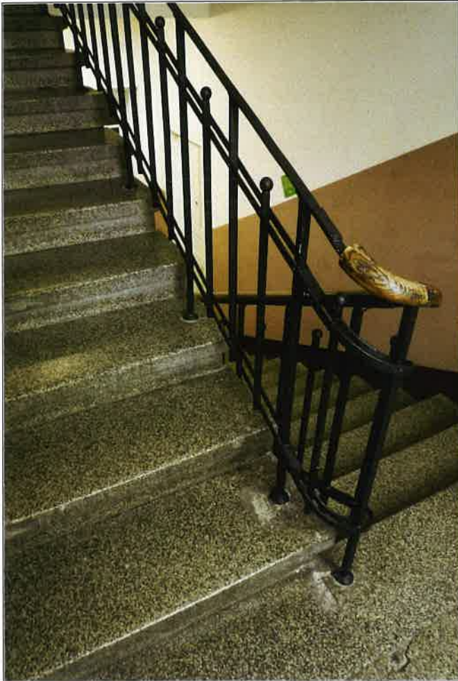
Schody oraz balustrada z fragm. Poręczy
