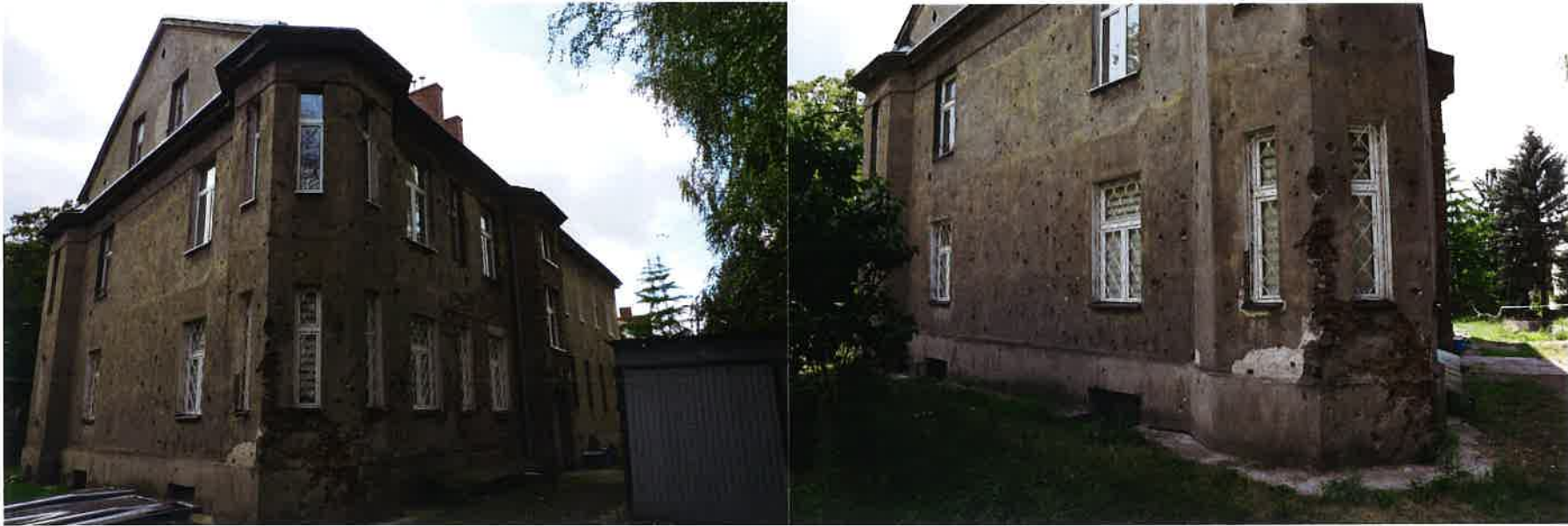
Widok na narożnik północno – wschodni.
