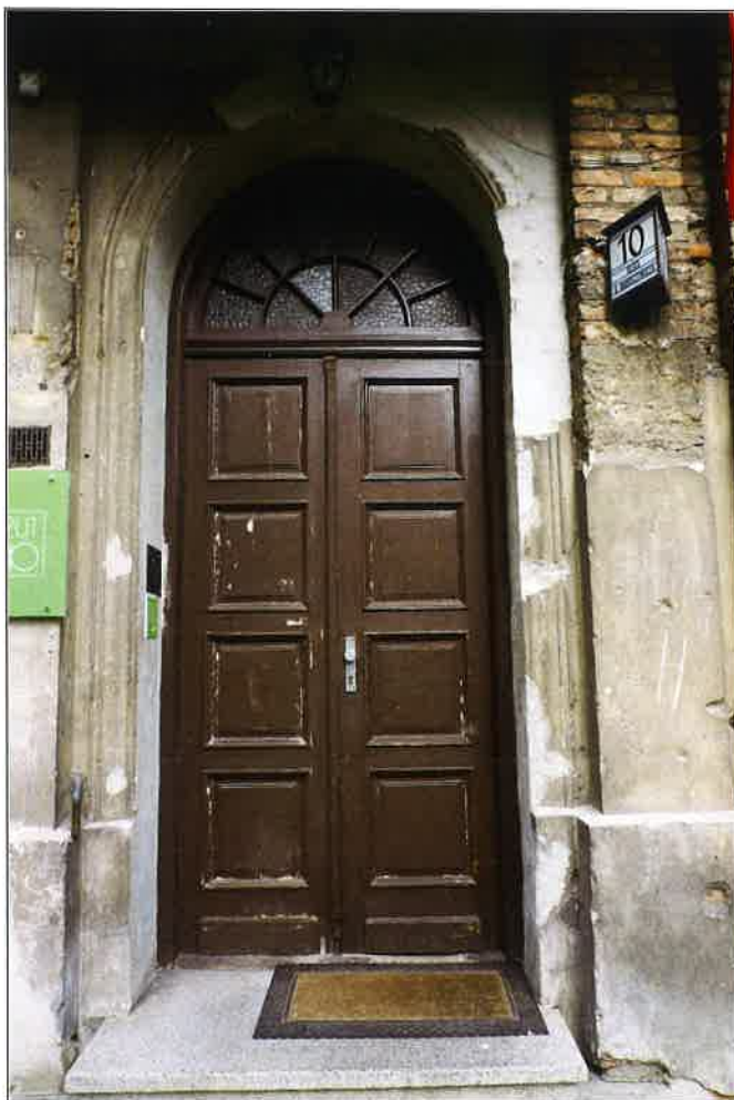
Drzwi wejściowe w elewacji frontowej.
