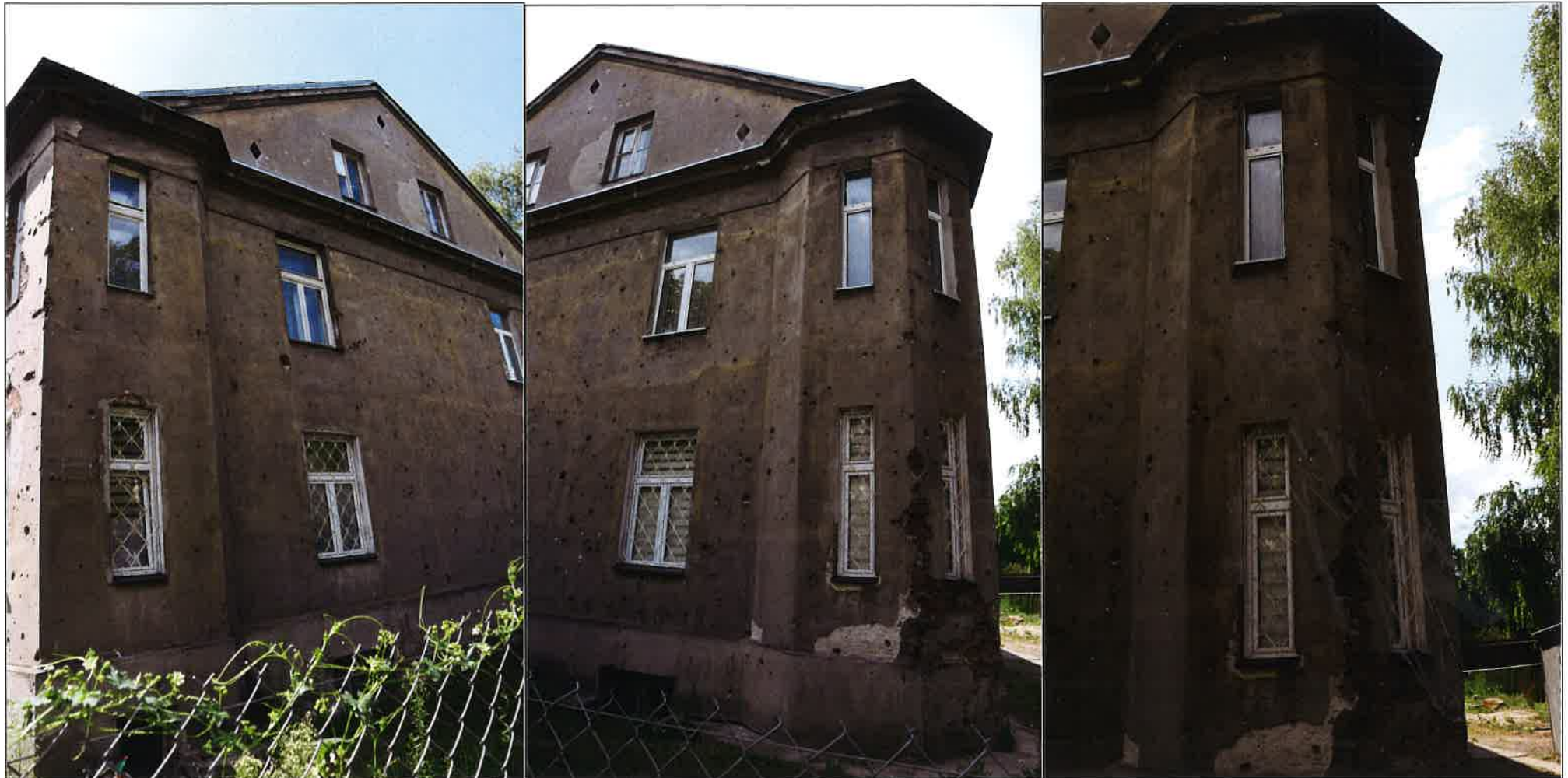
Widok na fragmenty elewacji wschodniej wraz aneksami w narożnikach.
