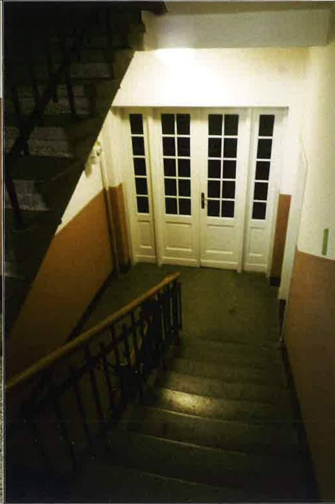
Widok ze schodów na przeszklone drzwi na parterze.
