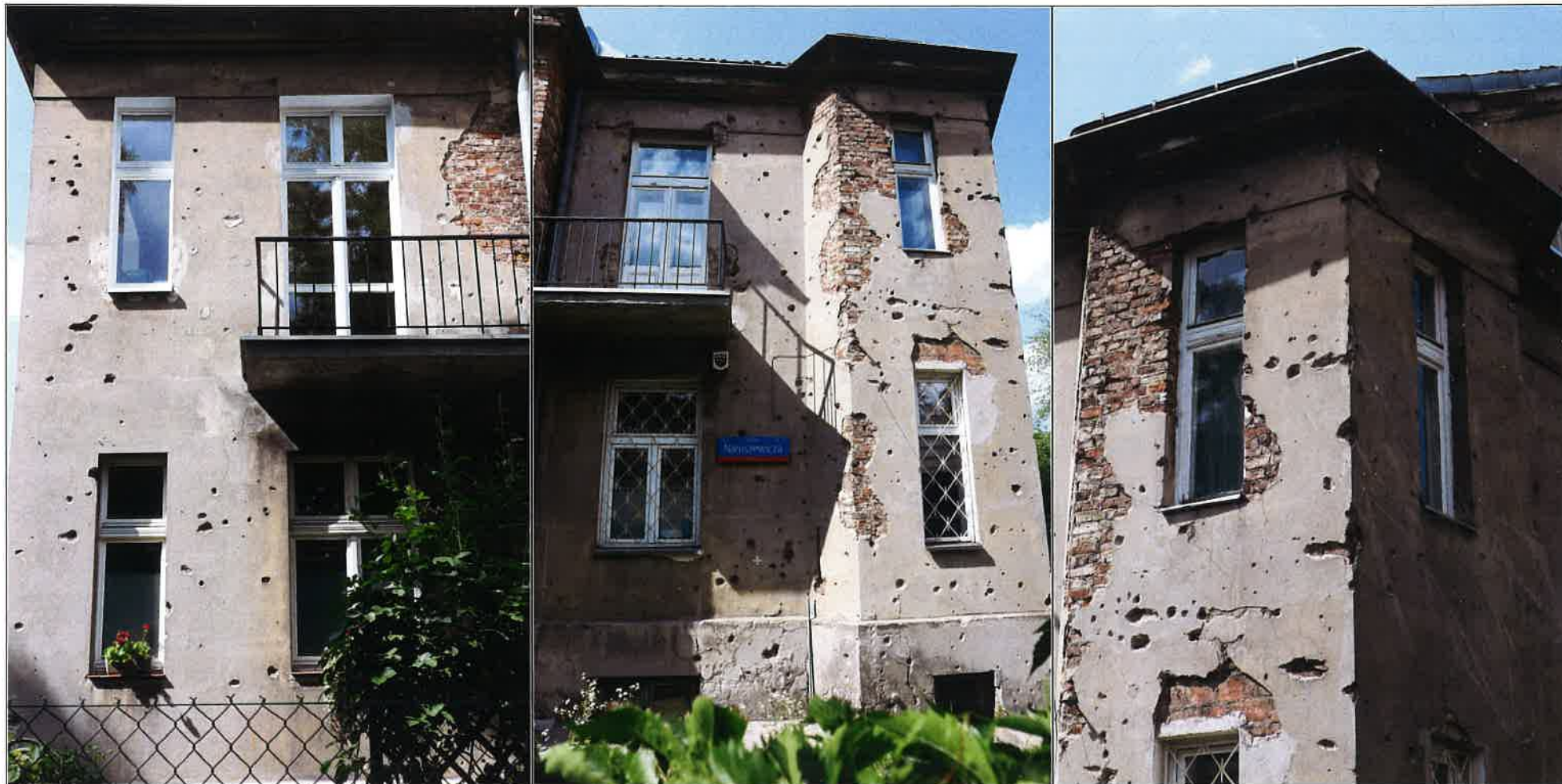
Fragmety elewacji frontowej.
