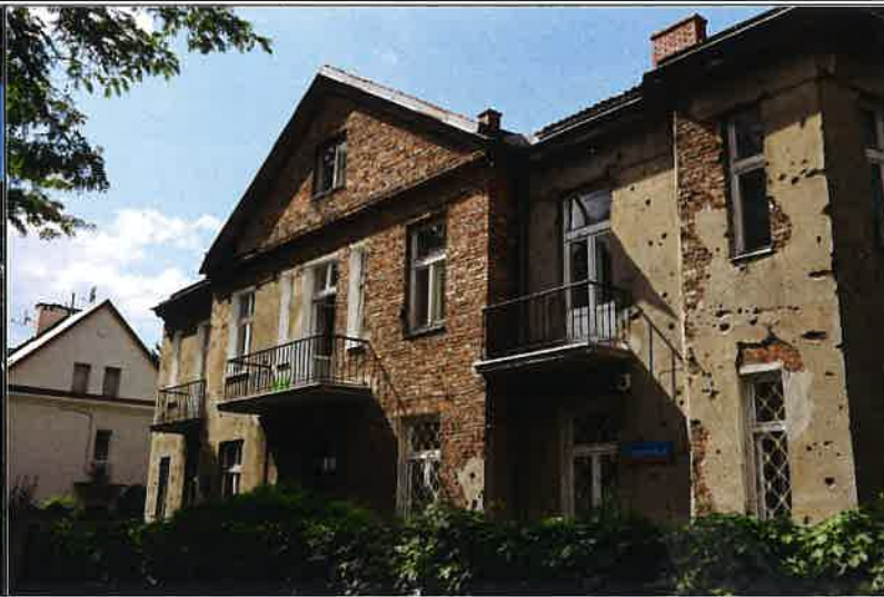
Widok na elewację frontową
