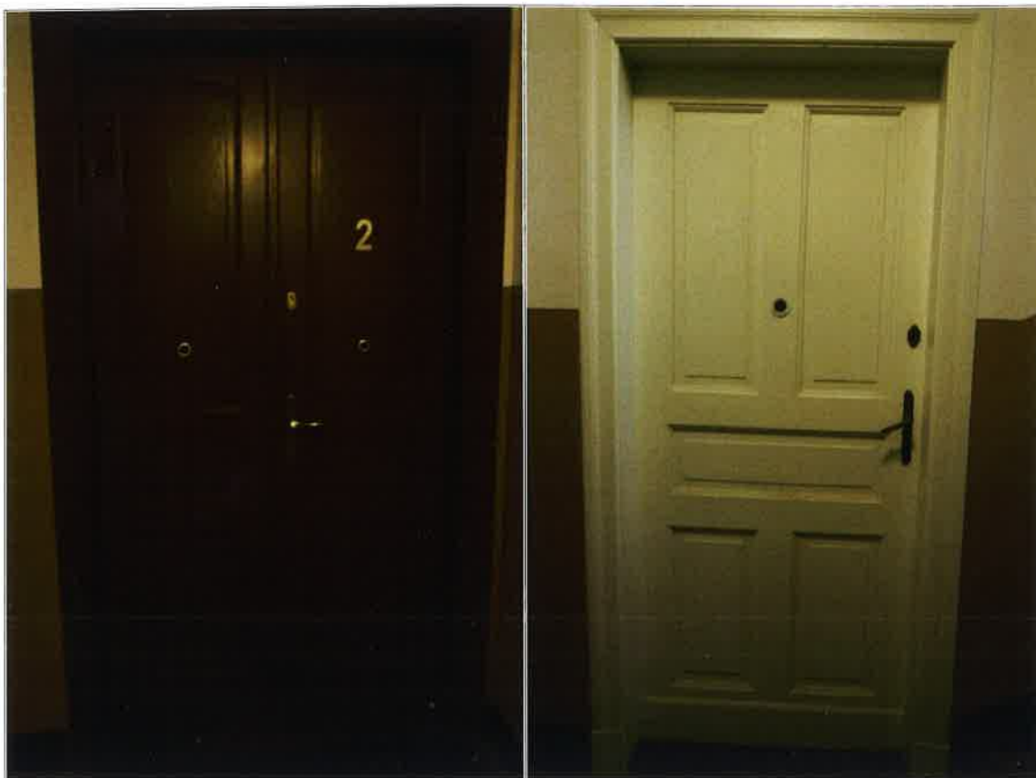
Drzwi wejściowe do lokali mieszkalnych
