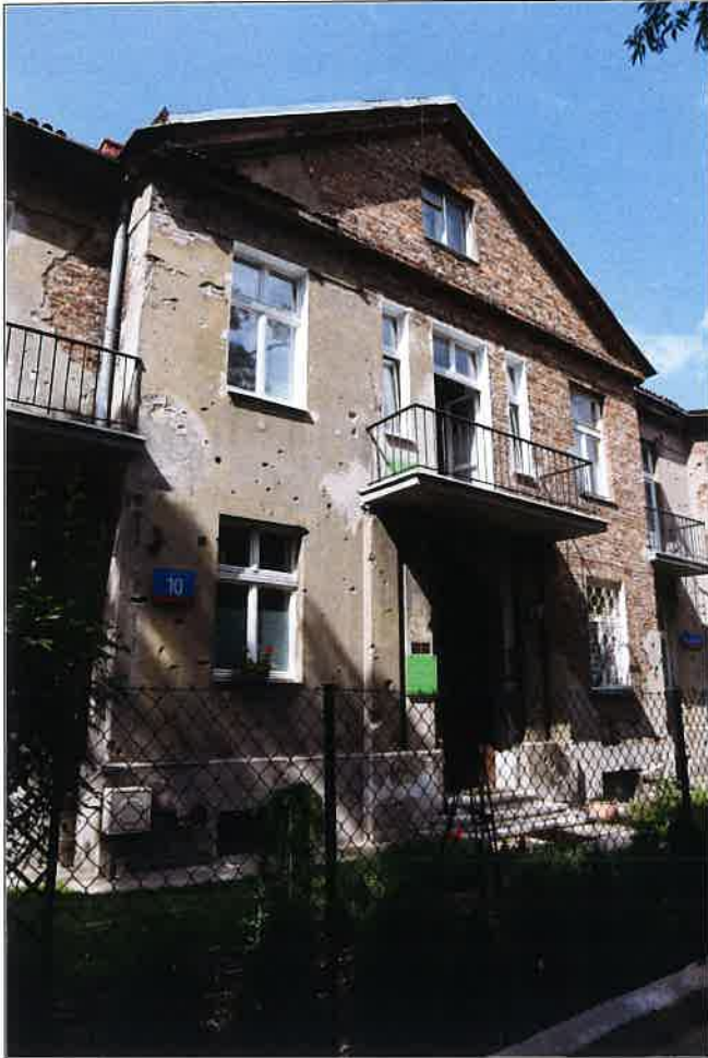
Widok ogólny na ryzalit w elewacji frontowej.
